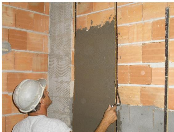
Figura 2 – Aplicação da argamassa de emboço em obra
