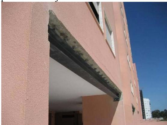
Fig. 12 – Reforço de laje através da introdução de perfis metálicos.
