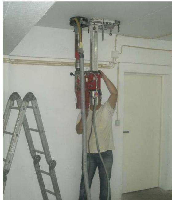
Fig. 10 – Extracção de carotes para avaliação da resistência actual dos betões.
